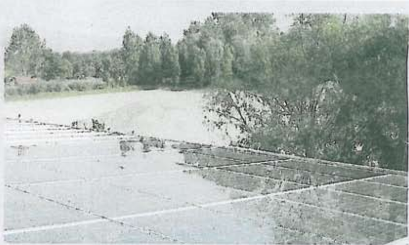
Installazione dei pannelli fotovoltaici alla Holcim di Peschiera Borromeo
